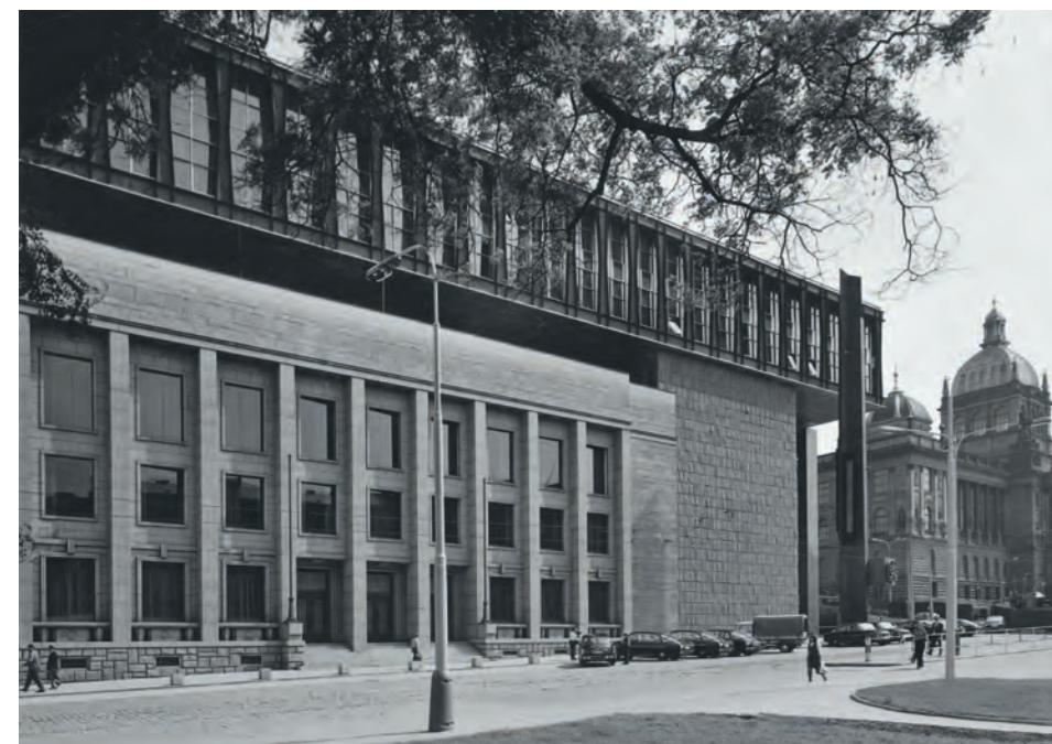
Budova Federálního shromáždění v Praze, současný a původní stav, foto původního stavu Kamil Wartha, archiv Radomíry Sedlákové
