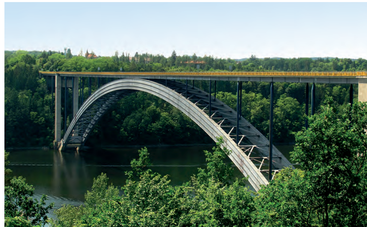
Žďákovský silniční most, foto Pavel Hájek
