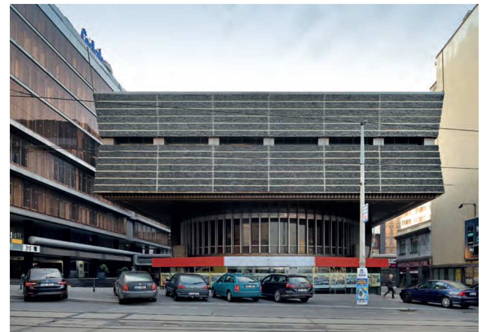
Komplex budov společnosti Transgas v Praze
